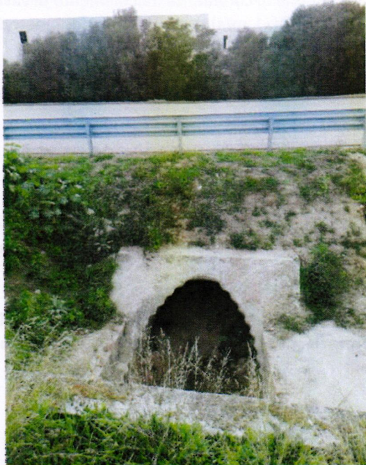
Figura 12 - Tombino di sottopasso di via Taiwan
