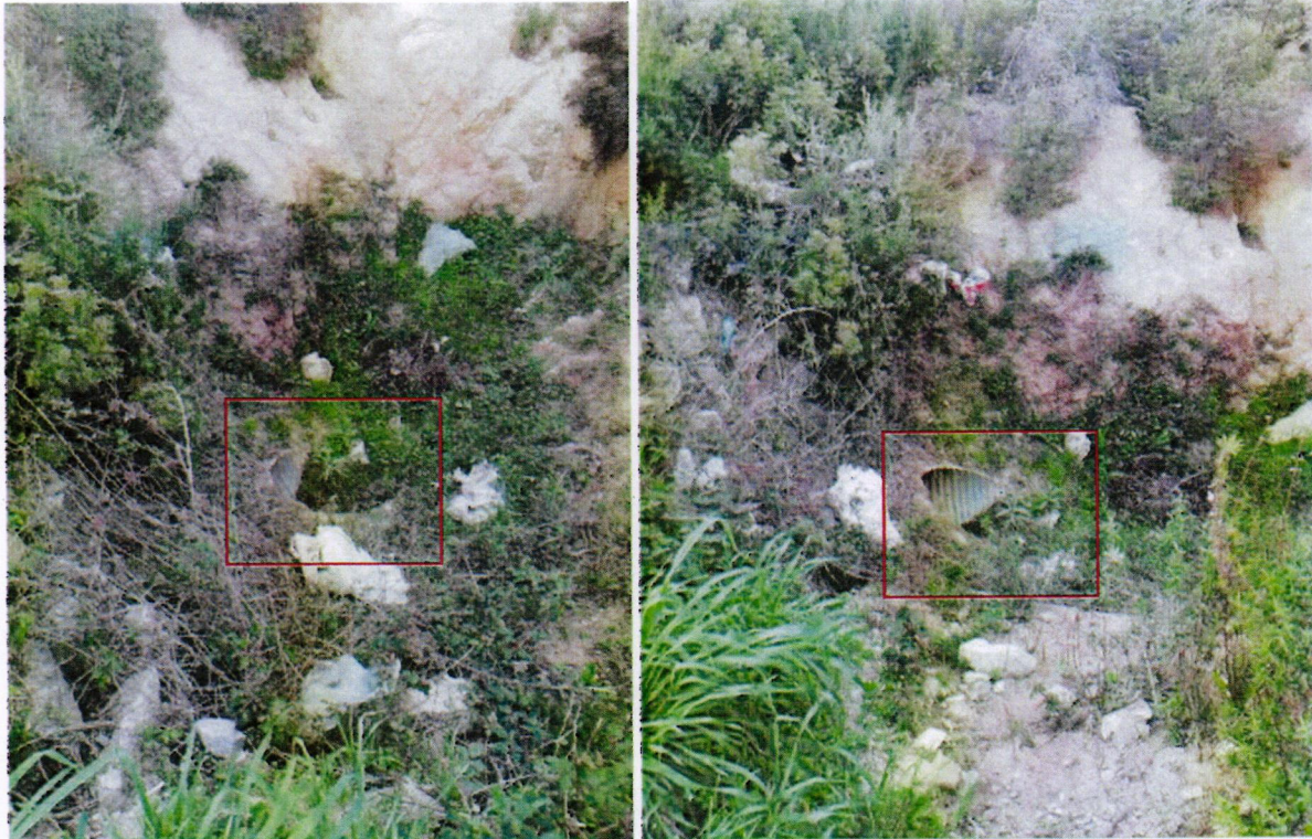
Figura 11 - Sezione di monte del tombino di sottopasso di via Thailandia – FIUME CIPNES via Thailandia 1
